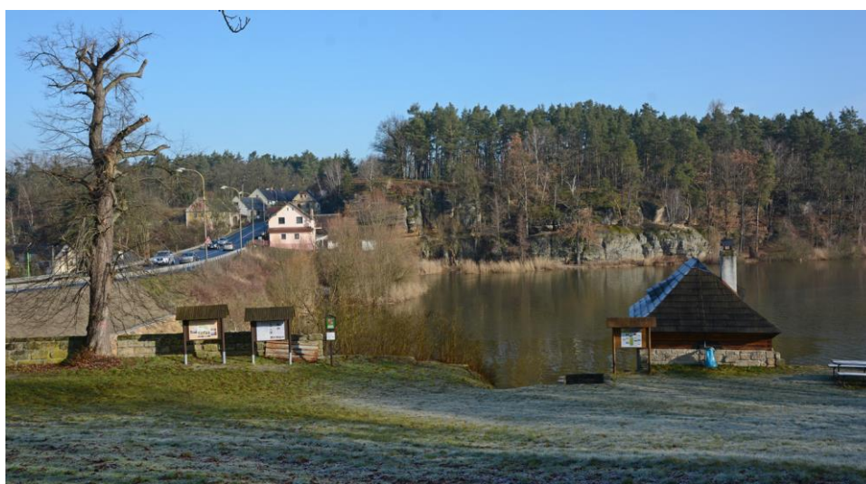
Obr. 25. Hráz Novozámeckého rybníka při pohledu od Staré pošty na sever. Po hrázi je vedena silnice I-9 na Českou Lípou. Foto J. Adamovič.
